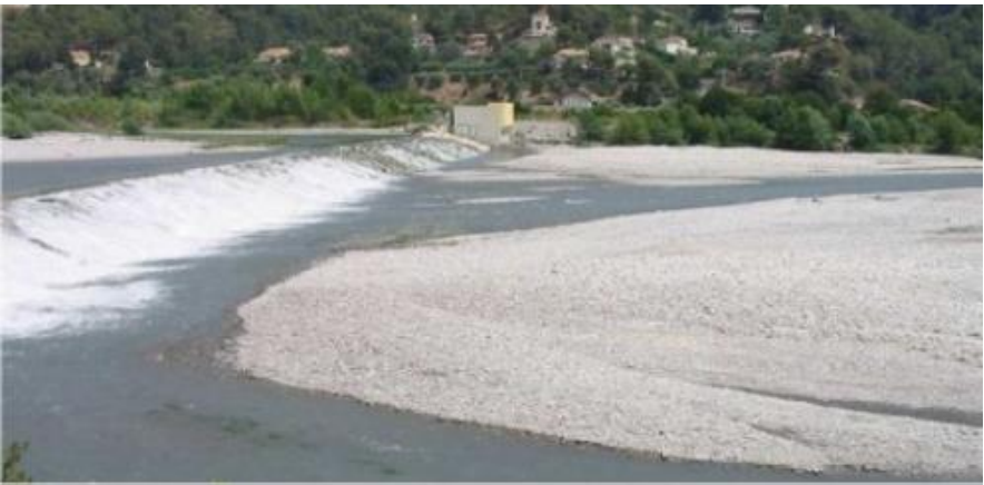
Seuil 9 : 5m de chute dont 3m engravé - avant travaux
